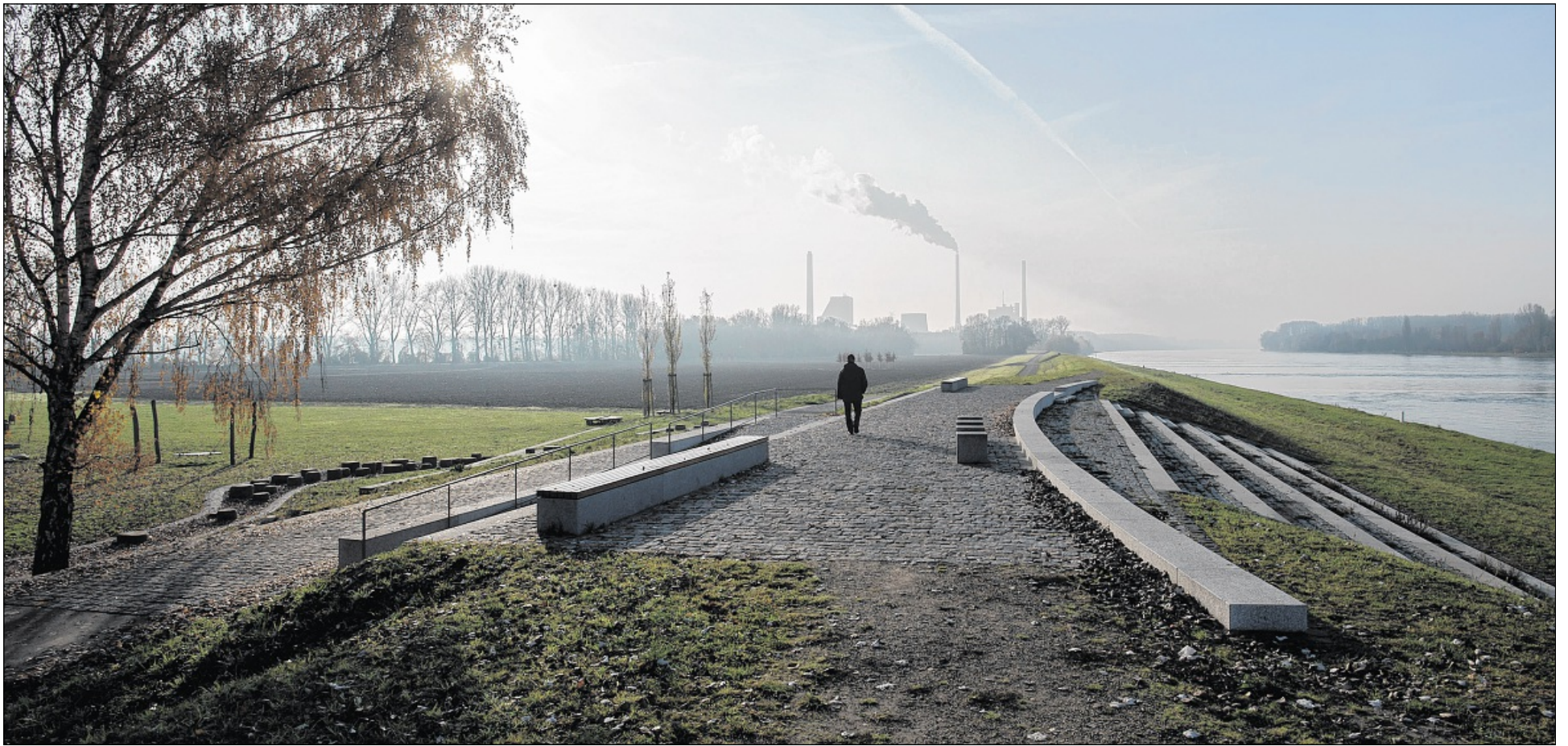
DER MAXAUER DAMMBOGEN, die Terrasse mit Sitzstufen und Blick auf den Strom, ist auch ein Aussichtspunkt aufs Hinterland zwischen Hofgut mit Spielplatz (links) und der Kraftwerkskulisse (hinten). Für den Landschaftspark Rhein wird dort jetzt das Feld in eine Weide verwandelt. Und junge Eichen sind gerade gepflanzt. Foto: Alábis
